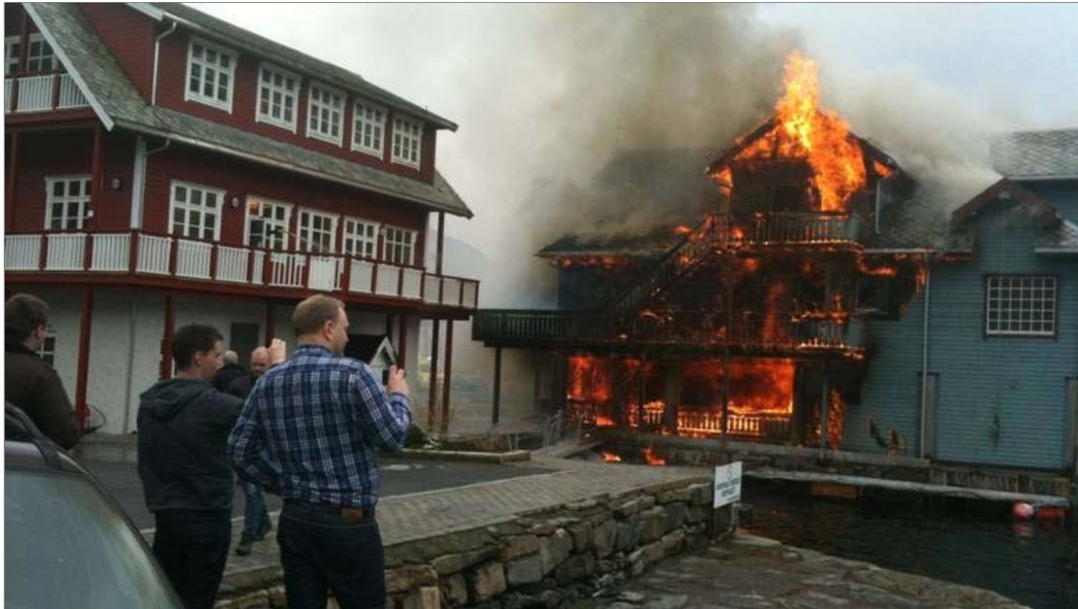
FLAMMEHAV: En person hoppet ut av det brennende bygget, ifølge politiet. FOTO: 2211-TIPSER
