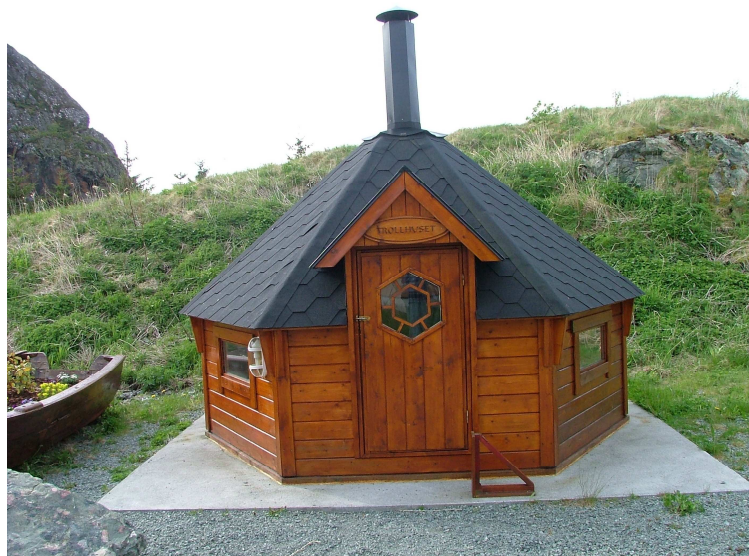
Das Grillhaus der Anlage
