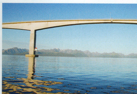
Die Brücke nach Stokmarknes (Fangplatz 7). In diesem Ort wurde übrigens die berühmte Hurtigroute gegründet.
