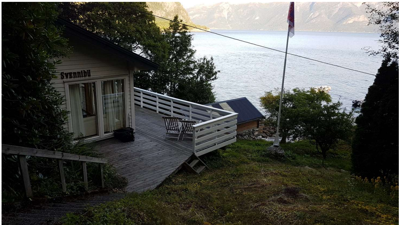
Bild 3: Blick von der Parkfläche auf Svennibu und den Sognefjord
