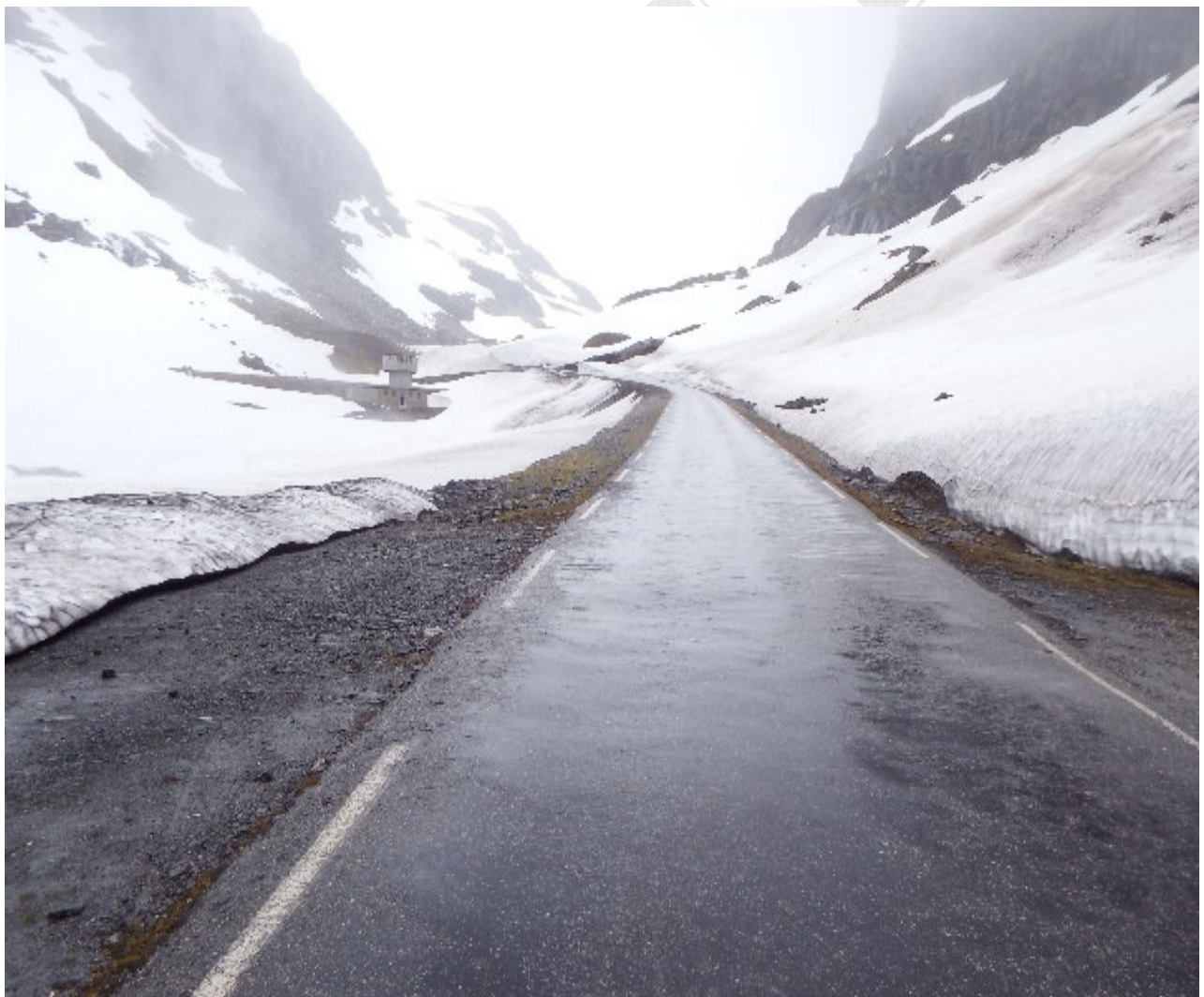
Bild 1: Die alte E 134 oberhalb des Haukelitunnels
