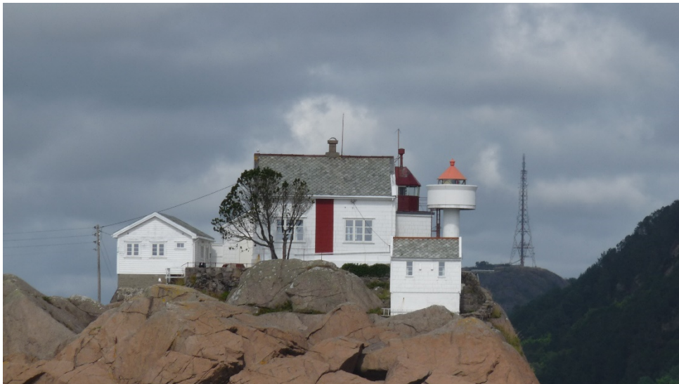
„Leuchtturm“ am Süden des Sundes.
