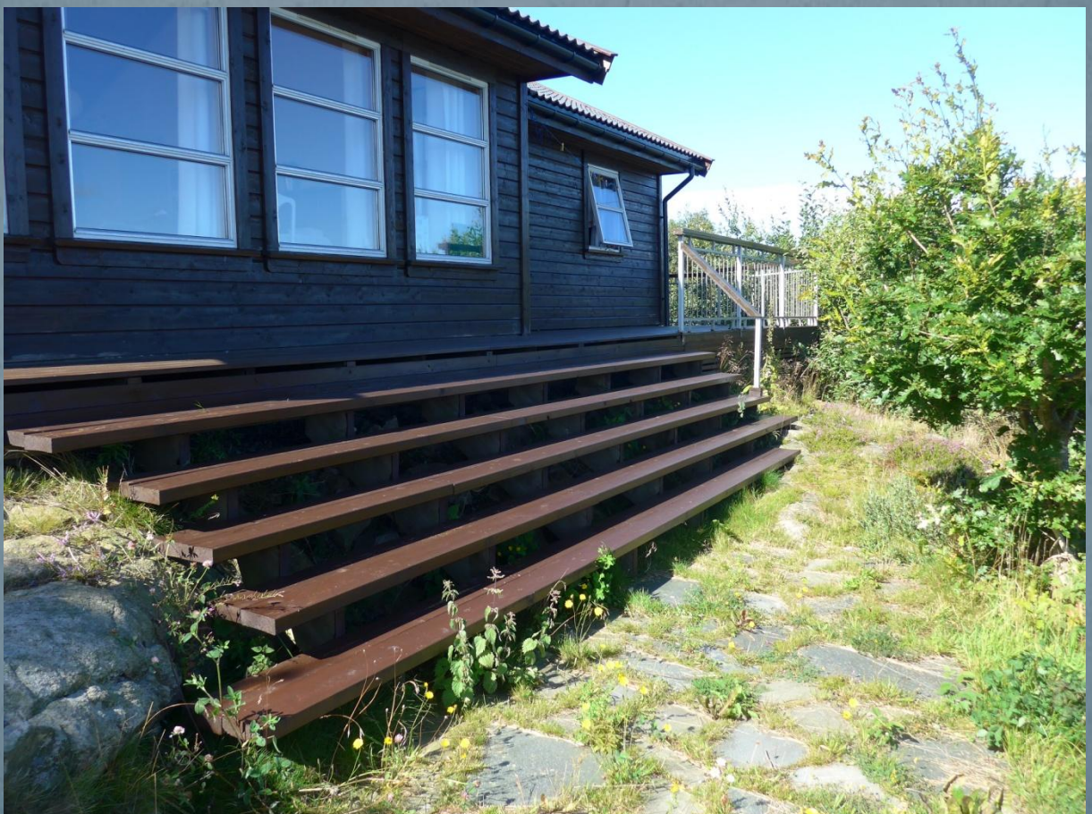
... die einmal ums gesamte Haus geht. Aber Vorsicht: „Absturzgefahr“
