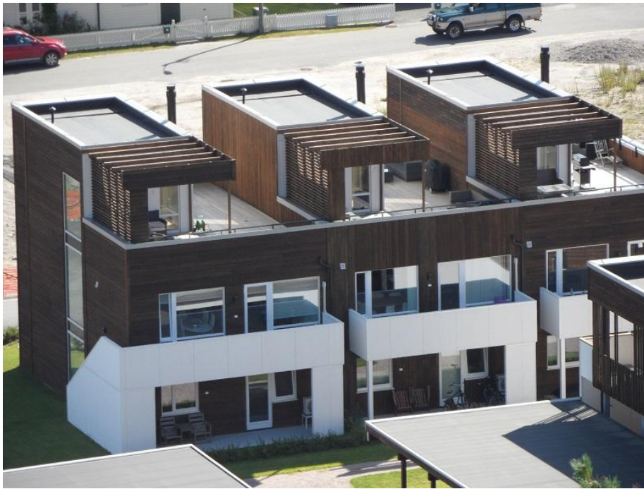
Alle Wohnungen hatten entweder Balkon oder Terrasse.
